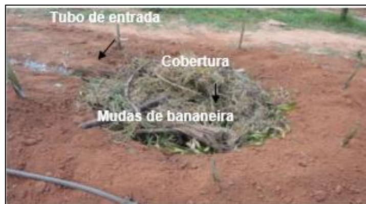
Figura 11 – Foto Ilustrativa – Construção do Círculo de Bananeiras Fonte: EMATER, adaptado por SAMENCO (2019)
