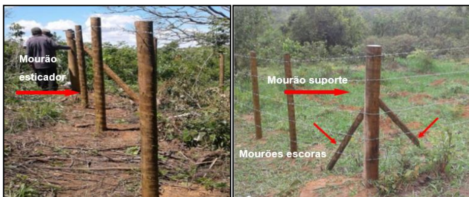
Figura 21 – Fotos Ilustrativas do modelo adotado para cercamento das nascentes Fonte: Localmaq (2017) - Município de Lassance, adaptado por SAMENCO (2019)
